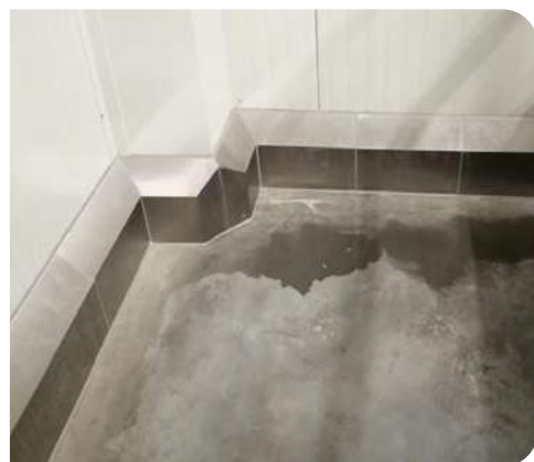
Paracolpi prefabbricato PolySto in acciaio inox ICS30R con anima in calcestruzzo.
