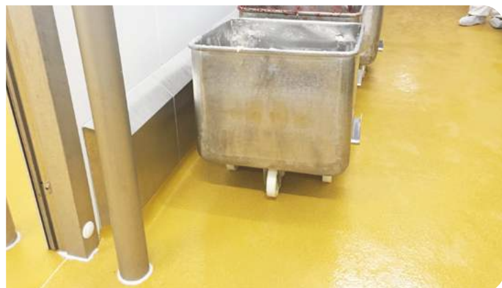
Paracolpi prefabbricato PolySto in acciaio inox ICS40RB con anima in calcestruzzo con pavimento in resina applicato in battuta.
